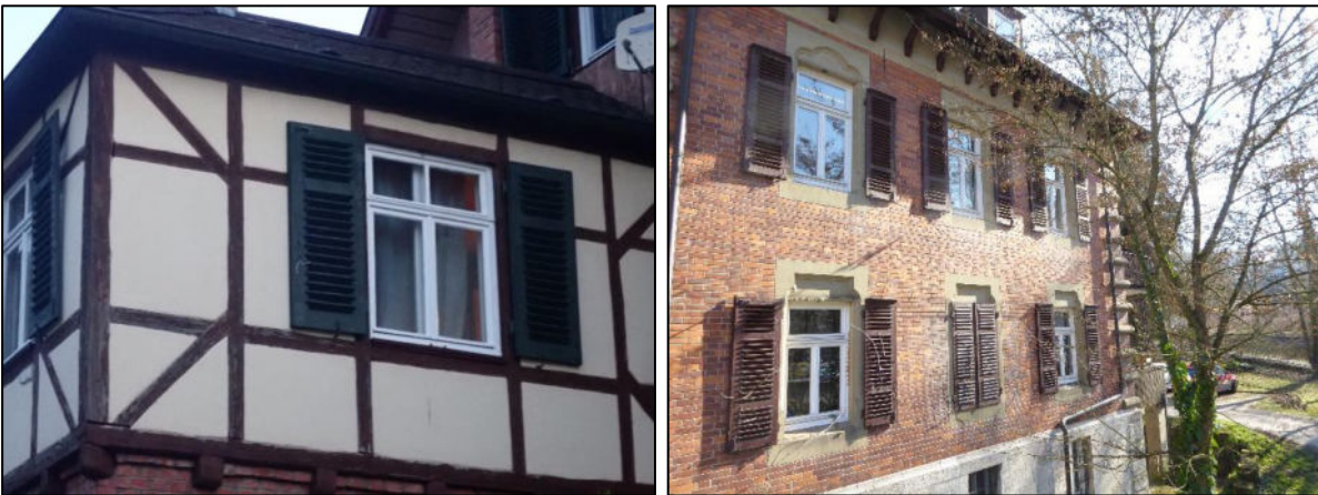
Abbildung 8: Als Einzelquartier von Fledermäusen geeignete offen stehende Fensterläden an den Gebäuden der Stuttgarter Straße 17 (linkes Bild) und der Stuttgarter Straße 21 (rechtes Bild).
